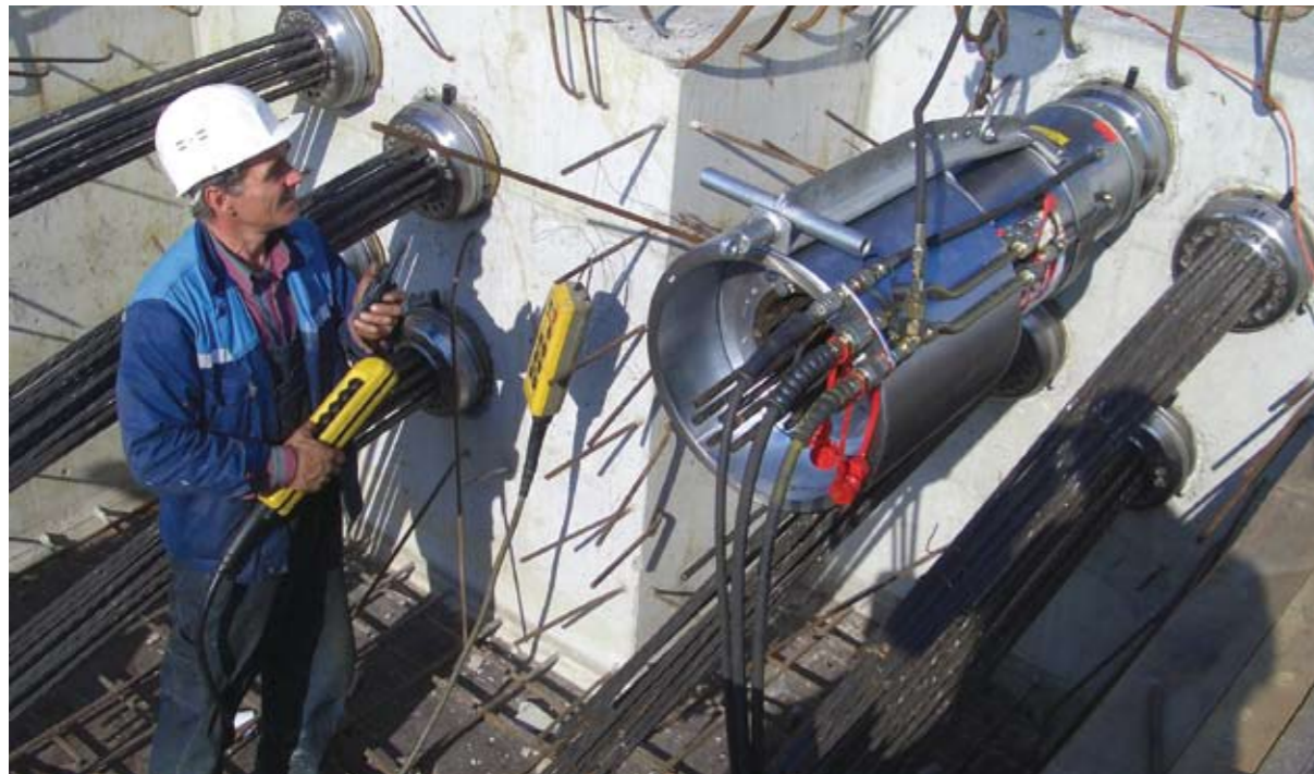
Įtemptami Konstitucijos pr. / Ukmergės g. estakados lynų pluoštai.
