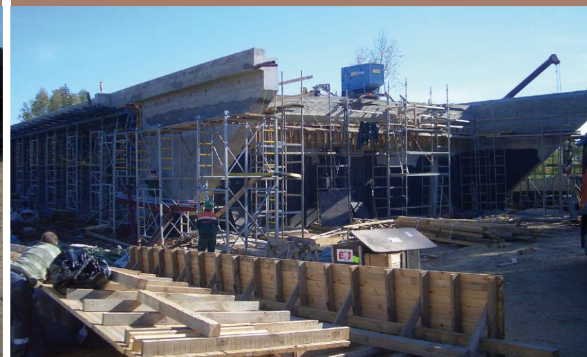
▼ Viadukas per V920 kelią dar kol kas vizualiai „kabo ore“, tačiau vėliau iki tilto perdangos lygį bus supilti kelio pylimai.
